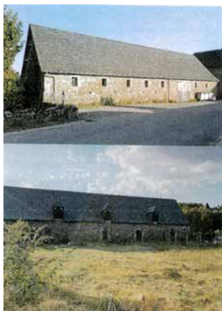
réhabilitation d'une ancienne propriété en résidence sénior et intergénérationnelle à Davignac
