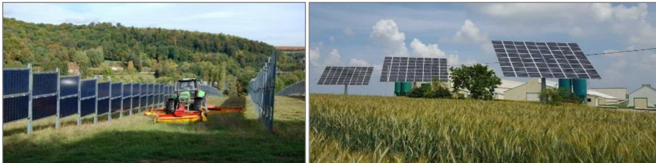
Photographie 3 : Parc photovoltaïque de Dirmingen (Source : Next2Sun) et exemple de panneaux « tournesol » en grande culture (Source : OKwind.fr)
