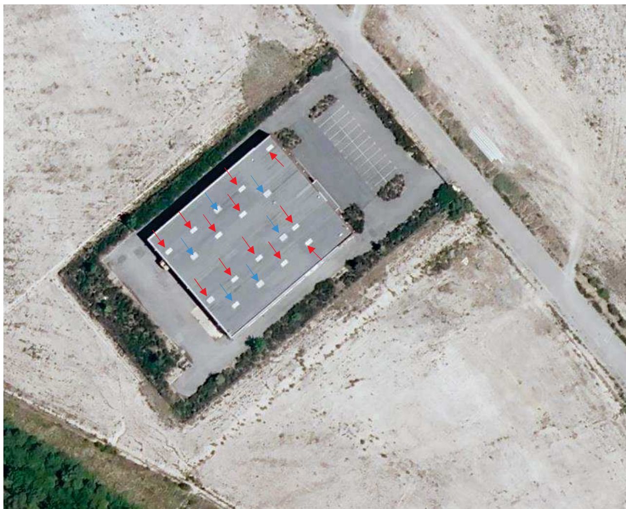
Vue aérienne de la répartition des dispositifs de désenfumage existants
