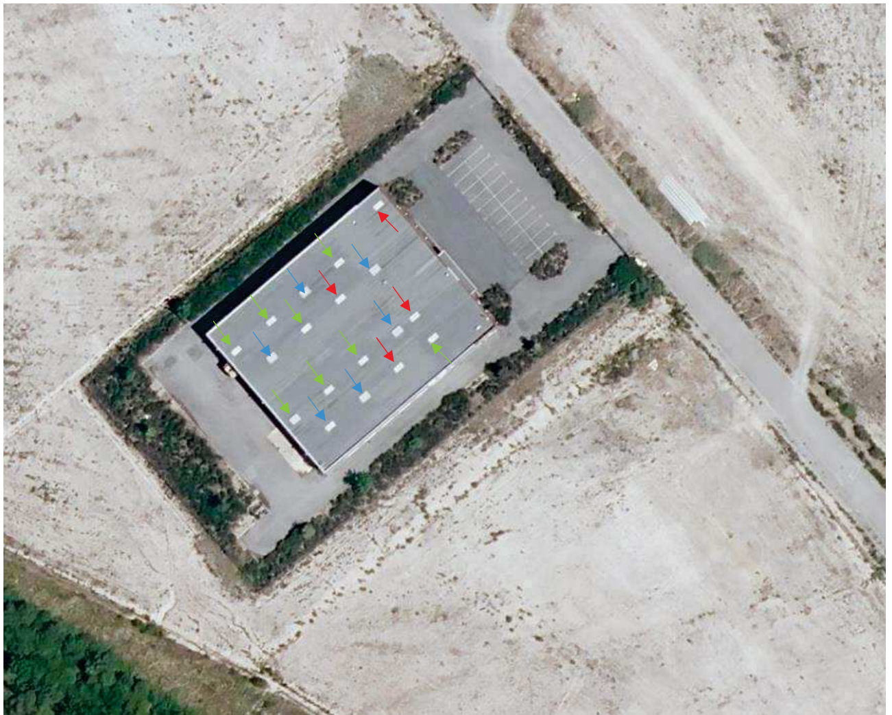
Vue aérienne de la répartition des dispositifs de désenfumage après travaux
