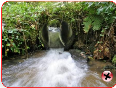
Trop forte vitesse d'écoulement
