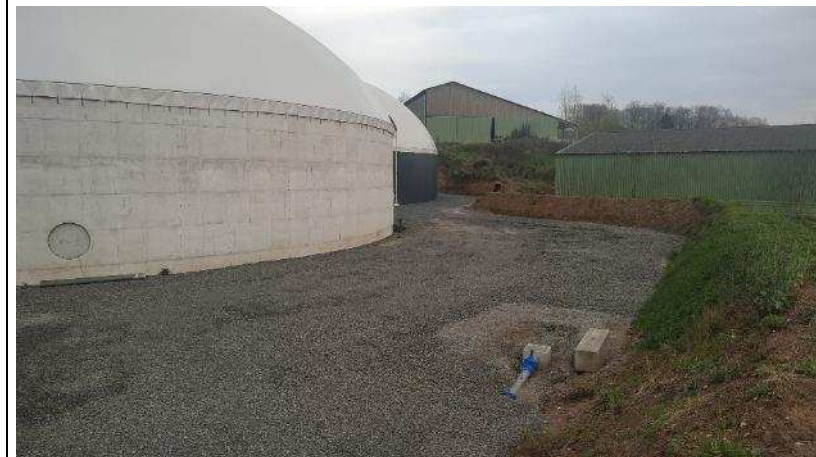
Zone process et talutage périphérique
