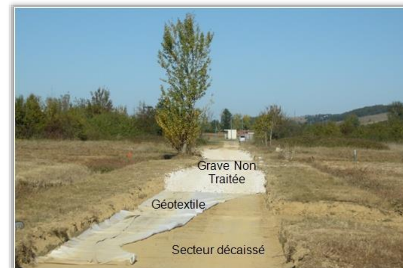
Photographie 15 : Mise en place d'une voie engins (lourde)
