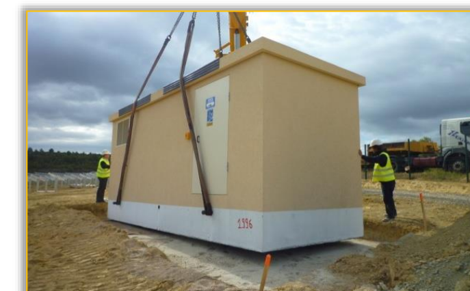
Figure 12 : Schéma de dépose des postes préfabriqués - Source : Transfix
