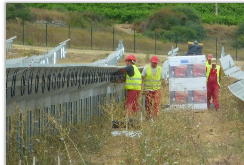
Figure 9 : Câblage et interconnexion des modules photovoltaïques
