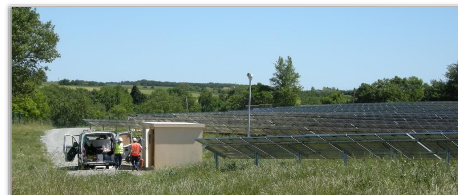
Photographie 23 : Opération de maintenance
