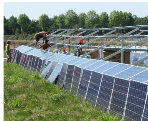
Photographie 54 : Pose manuelle des modules
