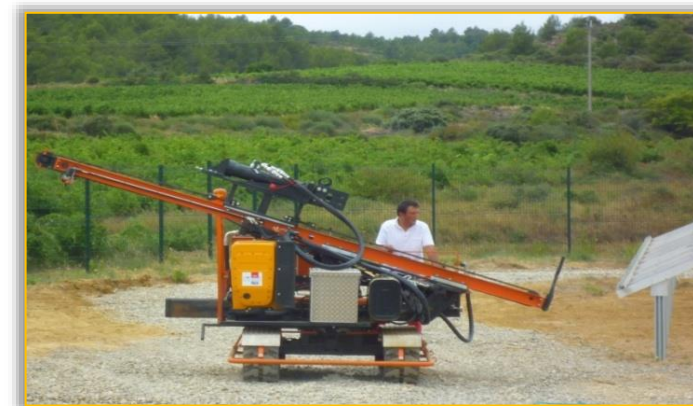
Photographie 18 : Machine de battage de pieux
