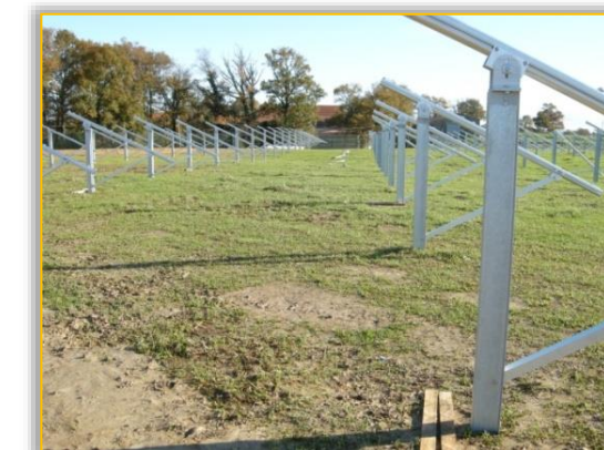
Photographie 19 : Structures prêtes à recevoir des modules
