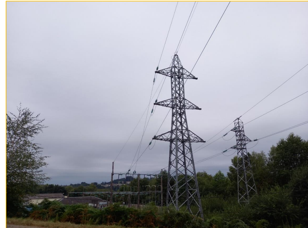
17) Vue depuis la RD3089 au niveau de l'entreprise Puybaret dépôt
