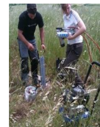
Photographie 9 : Test de résistance à l'arrachage des pieux
