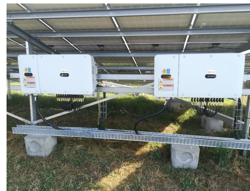
Photographie 10 : Illustration d'onduleurs string
