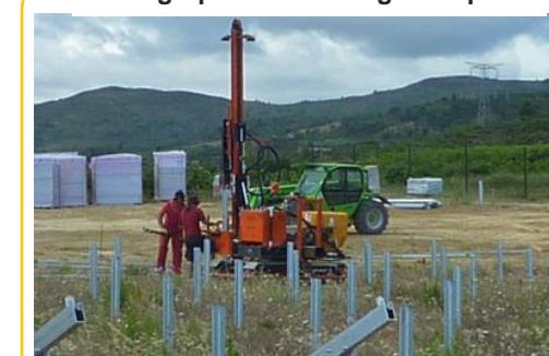
Photographie 52 : Battage des pieux
