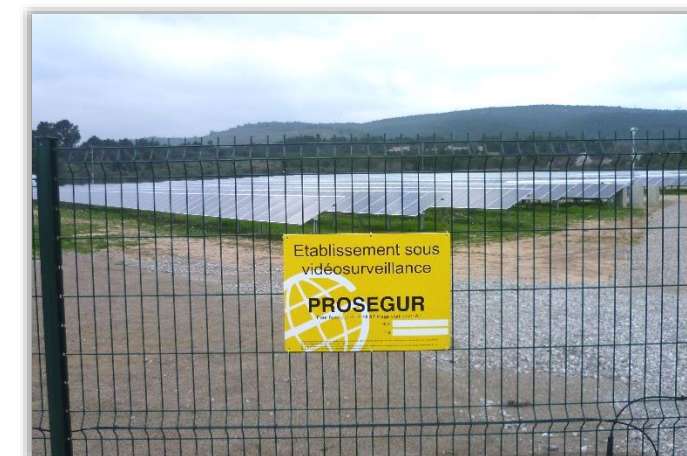
Photographie 14 : Signalétique de sécurité sur la clôture
