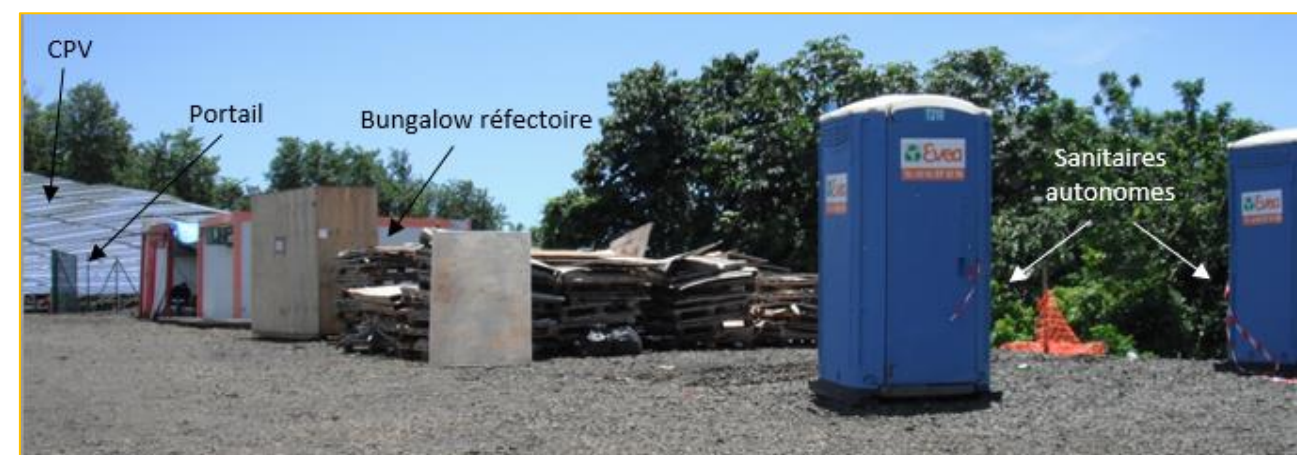
Photographie 58 : Organisation base de vie d'un chantier de CPV
