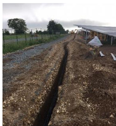
Photographie 17 : Tranchée pour la pose de câbles enterrés
