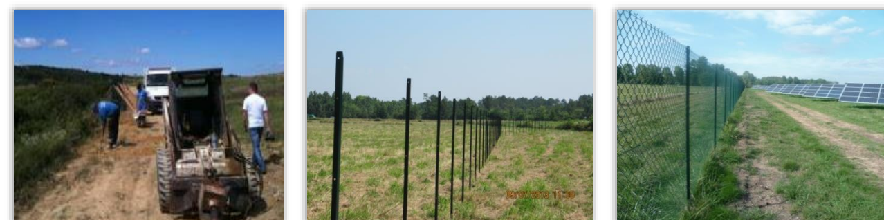
Photographie 12 : Mise en place de la clôture (pose des ancrages, des piquets et du maillage)
