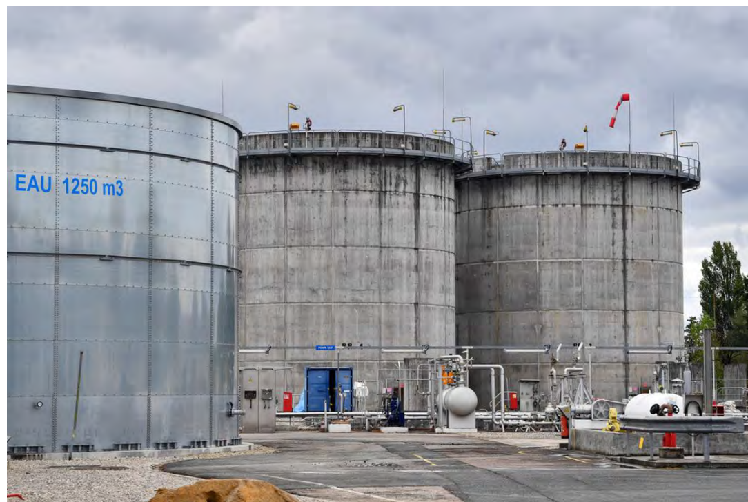
Figure 25 : Cuves de stockages sur le site Butagaz de Brive-la-Gaillarde (source : Frédéric Lherpinière, Lamontagne, 2019)
