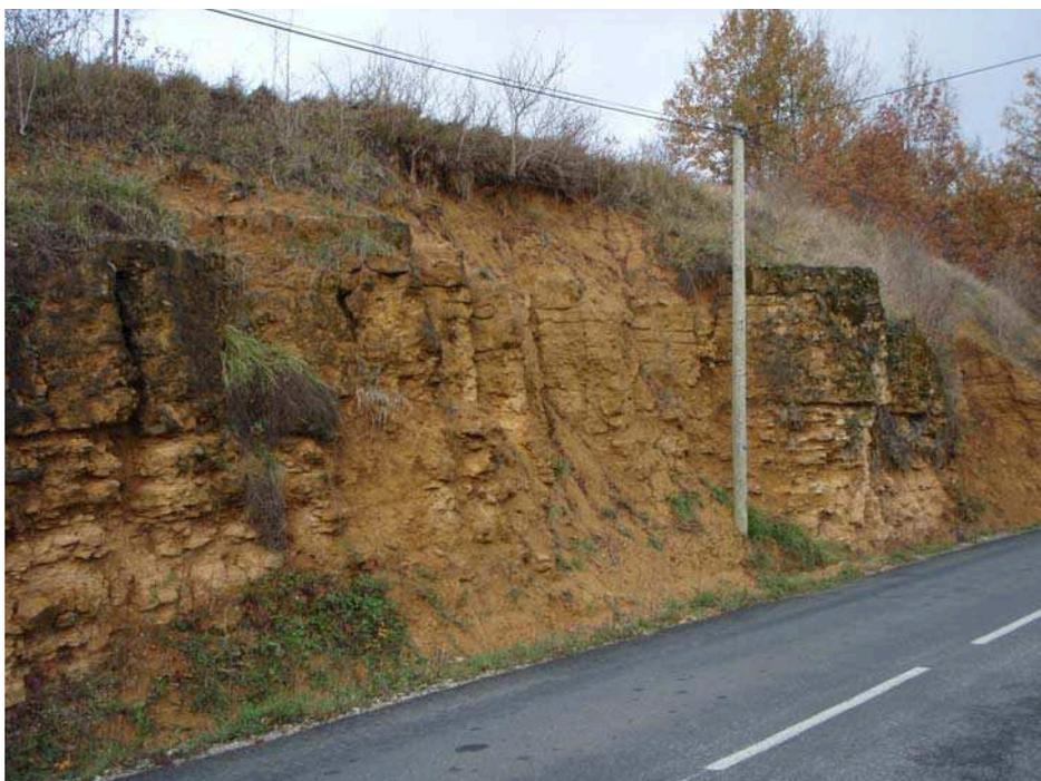
*Illustration 9 : Niche d'arrachement de l'éboulement survenu dans le talus de la RD 59*
