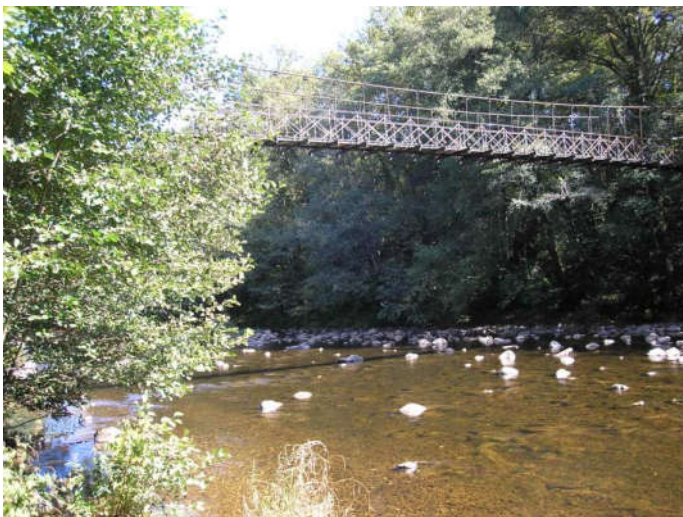
Fig 3 : aval du CAT - Passerelle
