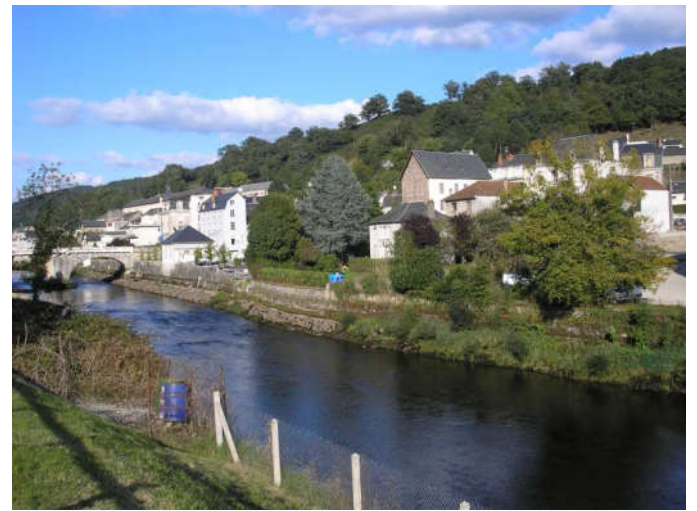
Fig. 6 : Aval du Vieux Pont
