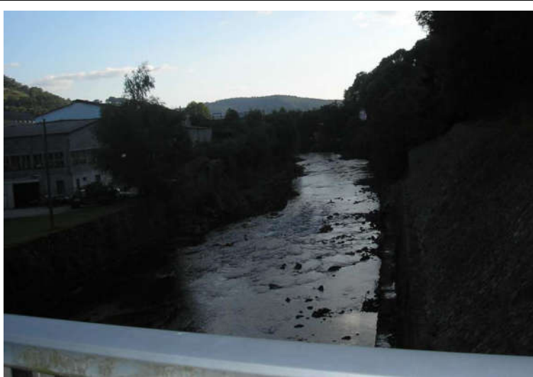
Fig. 1 : Aval du barrage – Section entièrement canalisée
