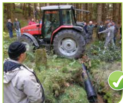
Tube PEHD* recouvert de rondins
