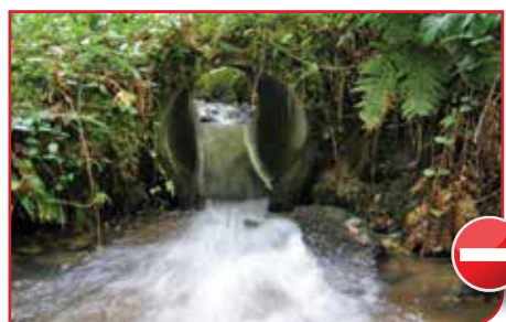
Trop forte vitesse d'écoulement.
