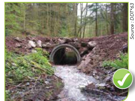
Buse circulaire enterrée au 1/3
