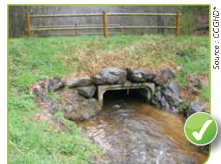
Buse cadre enterrée au 1/3
