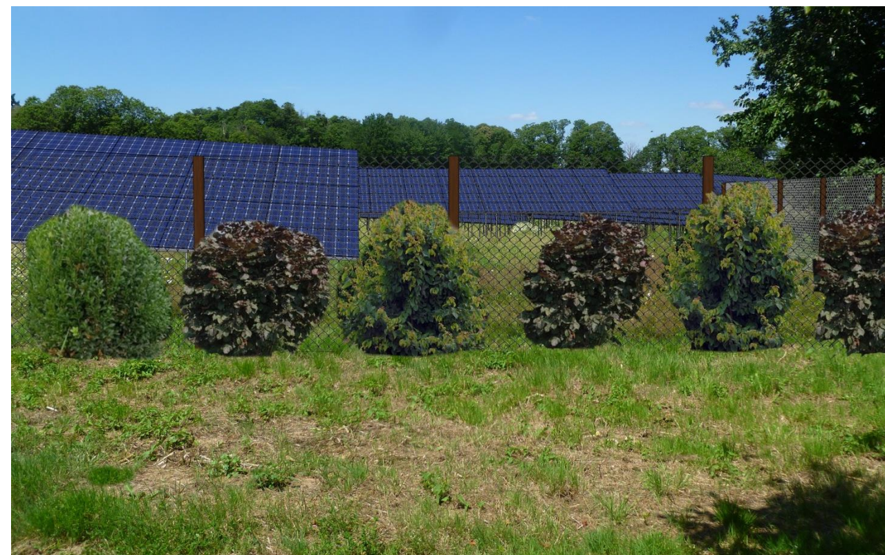
Photomontage 4 : Vue du projet de parc photovoltaïque depuis l'habitation n°5 après mesures
