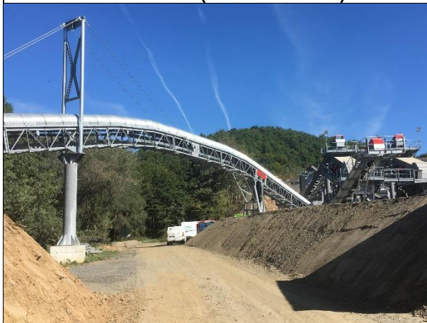
Bande transporteuse – passage au-dessus du chemin communal
