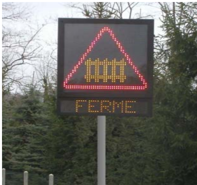
Illustration 9 : PMV asservi à la fermeture du PN
