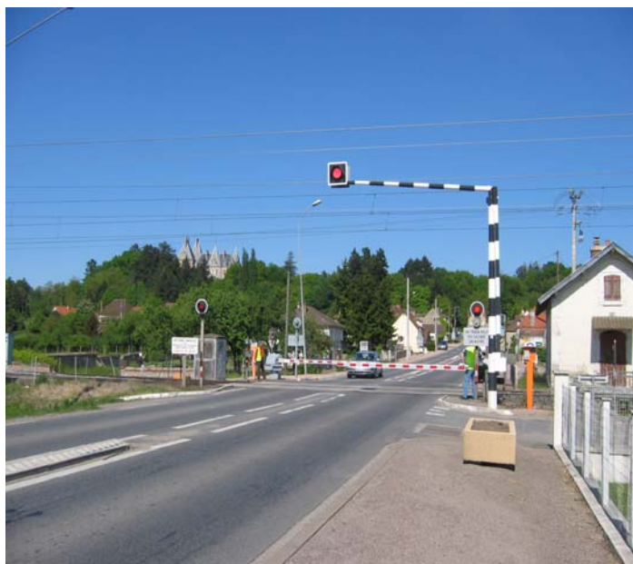
Illustration 7 : installation d'un feu R24 de 300mm en potence
