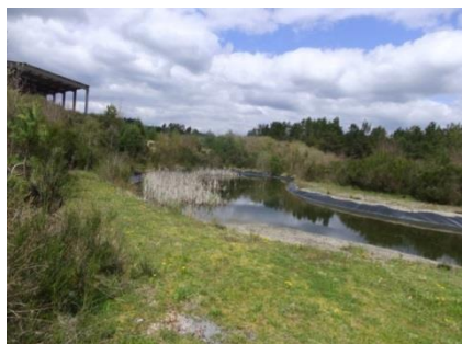
Bassin de rétention avec roselière
