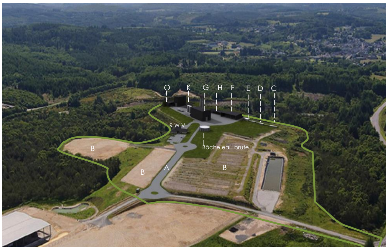
Figure 45 : Vue aérienne montrant les aménagements
