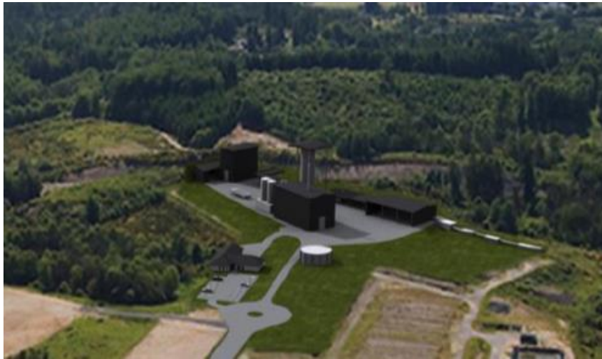
Figure 46 : Zoom sur la partie production de pellets torréfiés
