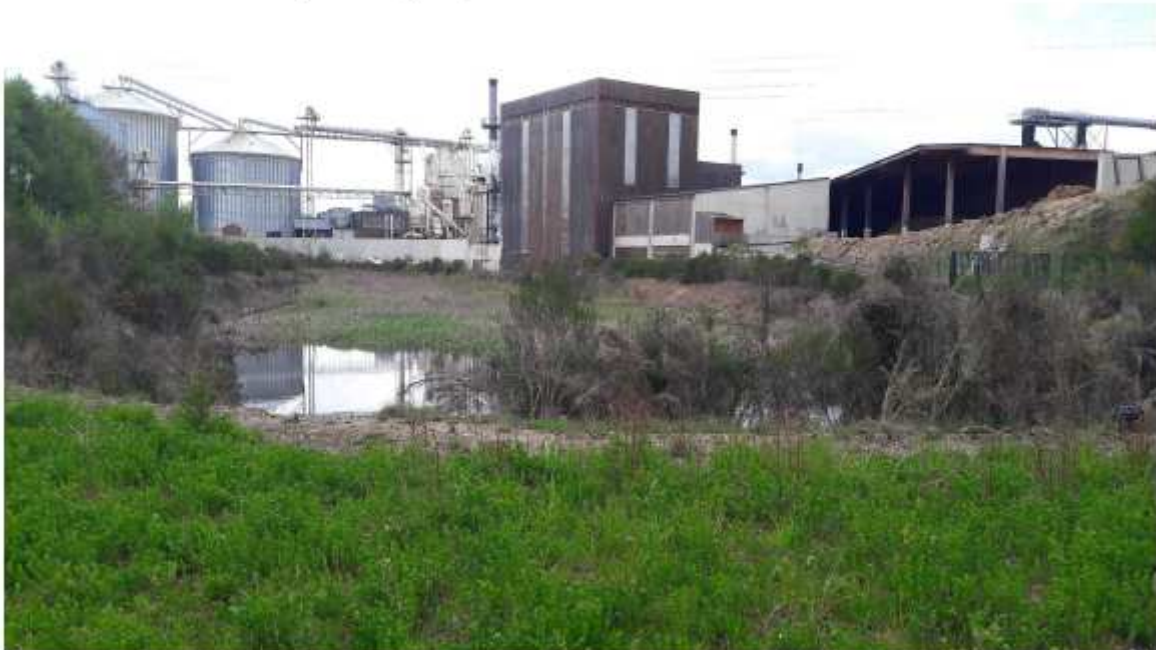
Chaudière à cogénération (F22) et silos de stockage vu de l'Est depuis la voie communale n°11. Au premier plan, le bassin du SYMA A89
