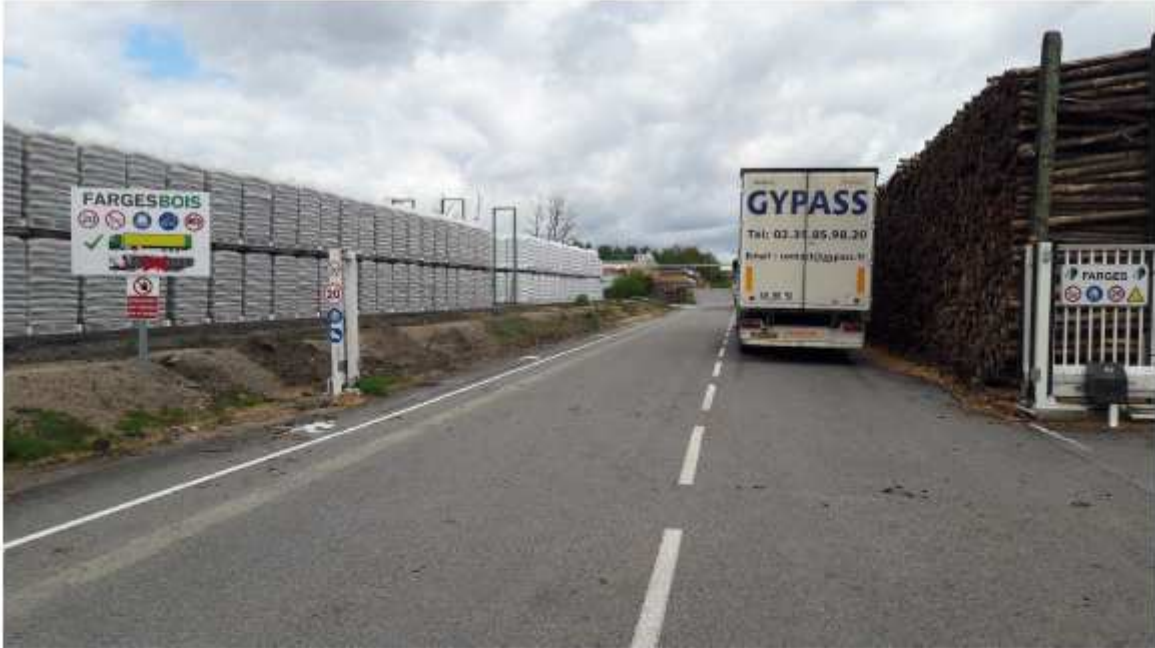
L'entrée sud du site vue de la rocade Est.
