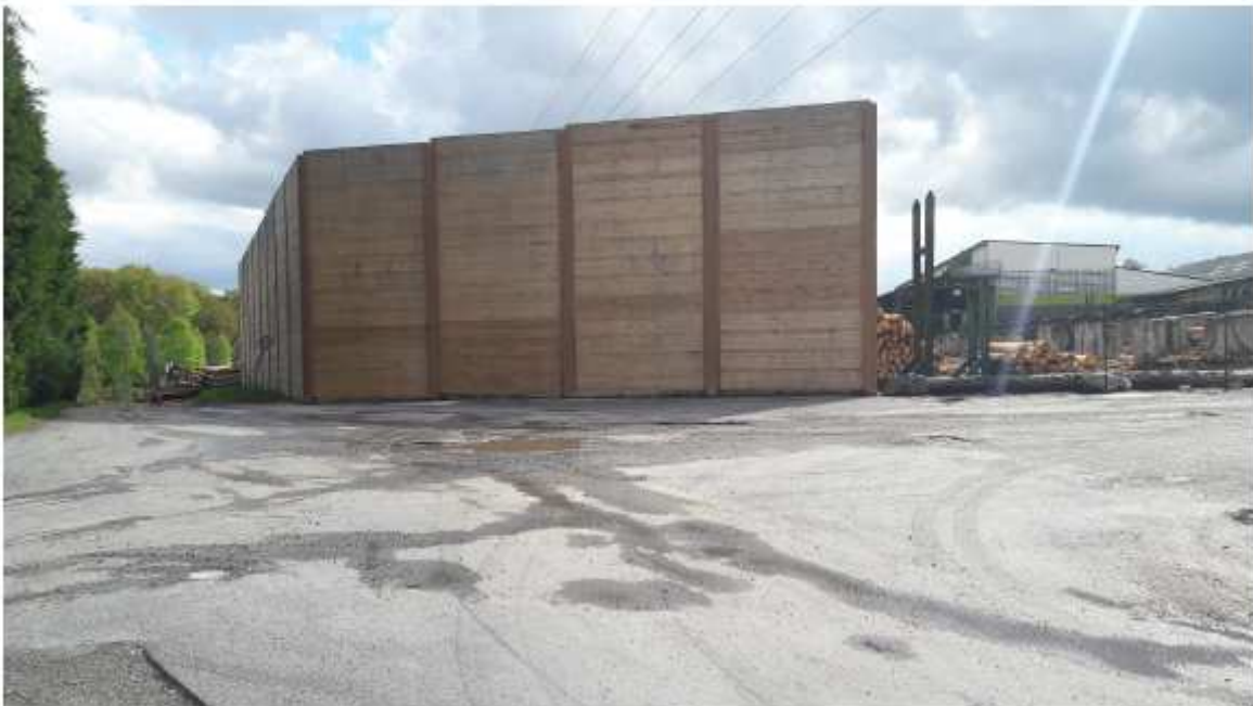
Ecran acoustique au Sud Est du site depuis l'extrémité Est de la rue Tra le Bos
