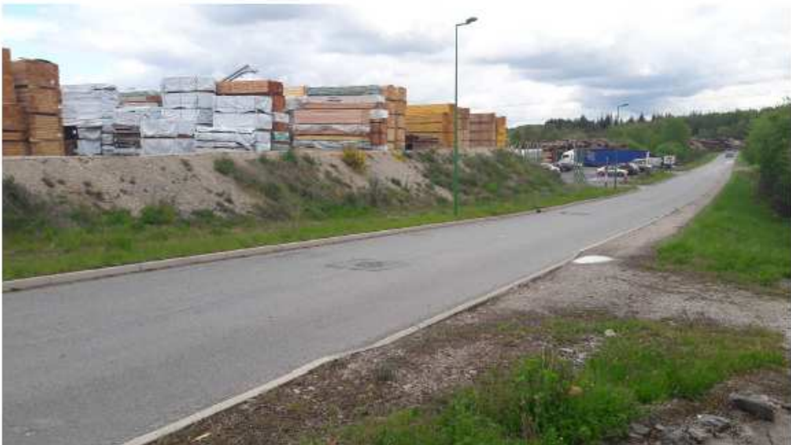
Plateforme Sud-Ouest du site vue depuis le Nord de la Rocade Est
