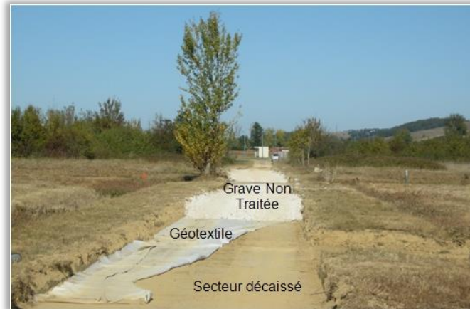
Mise en place d'une voie engins (lourde) (Source : LUXEL, 2011)
