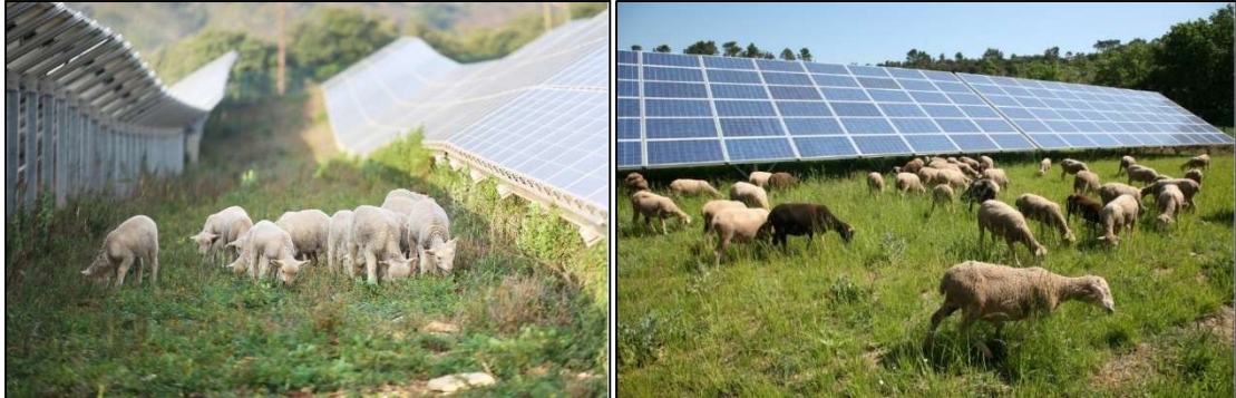
Entretien pastoral de centrales solaires ENGIE Green
