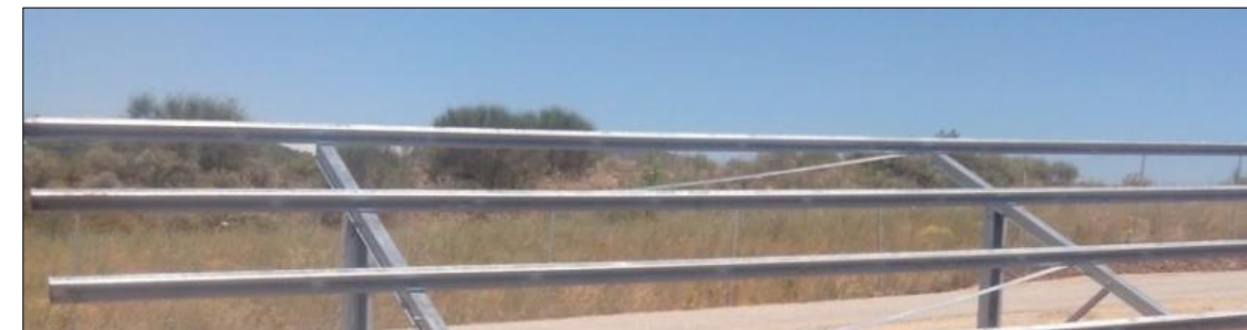
Structures bi-pieux inclinées (source : ENGIE Green)
