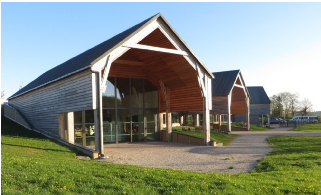
Construction contemporaine en prolongement des caractéristiques du bâti vernaculaire, gros volumes simples, intégration dans la pente, exemples à suivre
