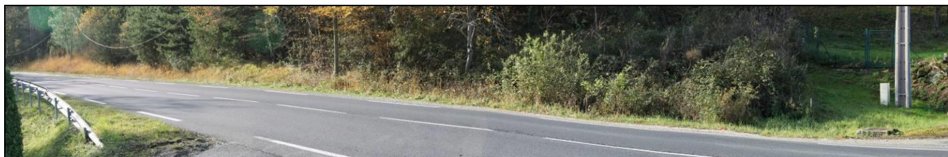
Sortie de la carrière, en direction du Sud (Montplaisir)
