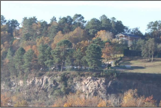
habitation isolée à 35 m à l'Ouest de la carrière
